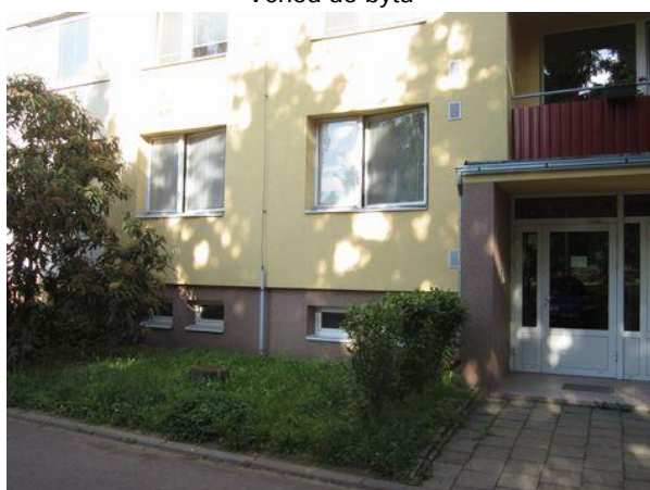
Okna bytu do ulice
