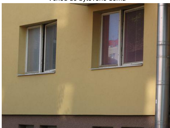
Okna bytu do zahrady za domem
